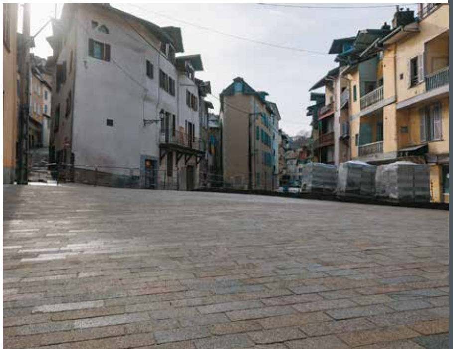
■ L'entreprise Sud-Ouest Pavage procède à la pose des pavés type parquet (en pierre de granit de Bugeat) pour matérialiser la zone piétonne.
