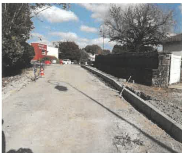
Aménagement rue de l'Aiguillon à Seilhac.
