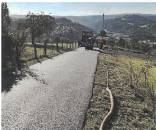
Section Route des Roches à Tulle.
