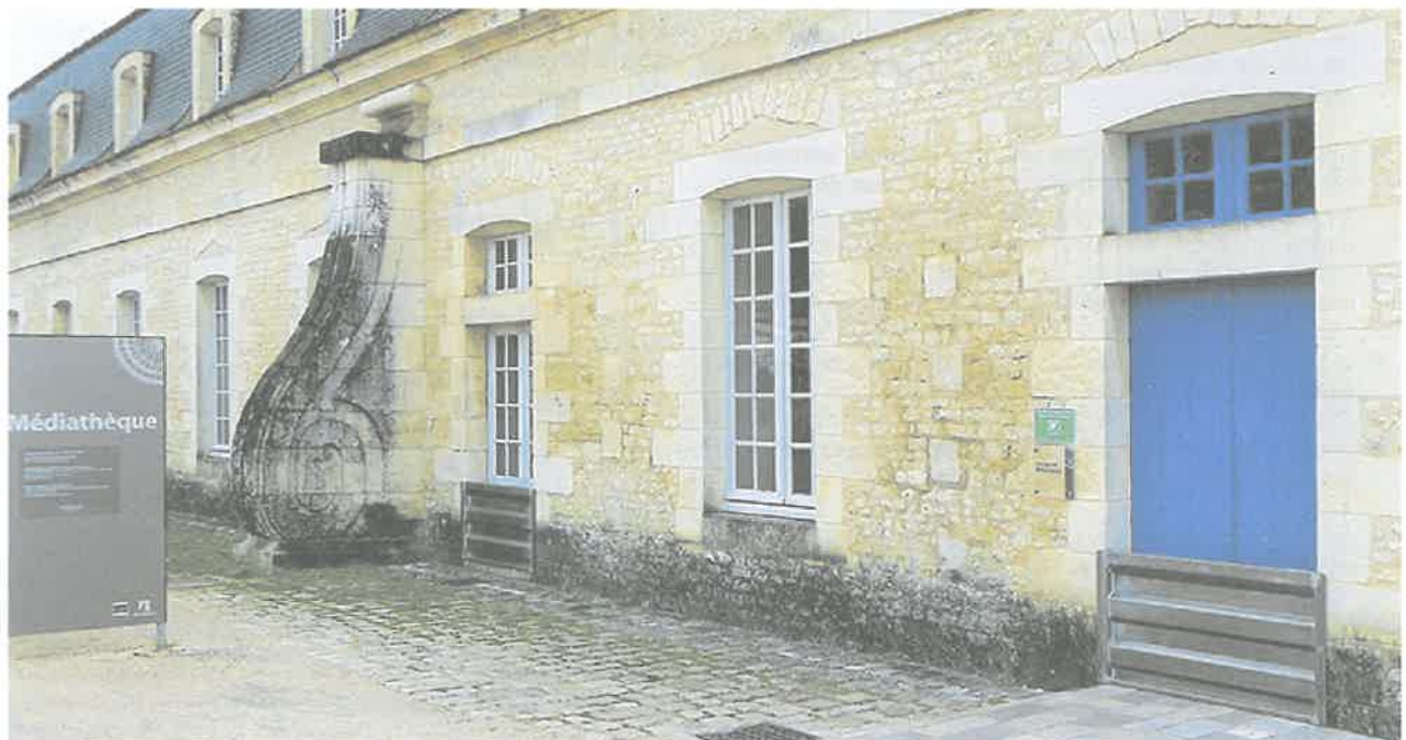
Batardeau à la Corderie Royale, à Rochefort (Charente-Maritime), 12 février 2015 Photo EPTB Charente
