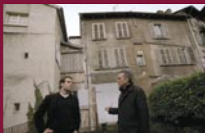
Jacques Agier, ici avec Mathieu Goury de la Semabl, dans la cour de s trois immeubles qui vont être restaurés dans le cadre du PRI sur l'avenue Charles de Gaulle.
