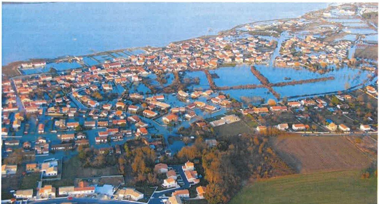
Inondation à Port-des-Barques, 28 février 2010 Photo DDTM17
