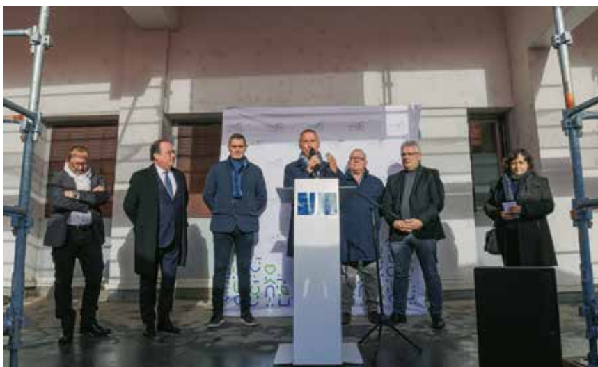
○ Lancement des travaux de la résidence Tour de Souilhac en présence des élus vendredi 6 décembre.
