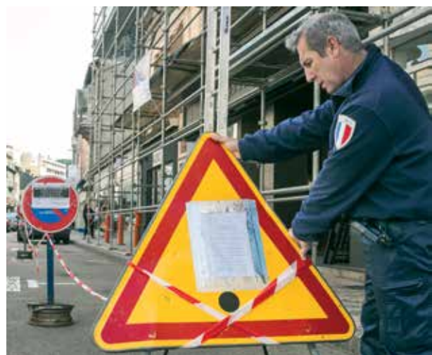
○ Les agents du SDP sécurisent les chantiers en ville.
