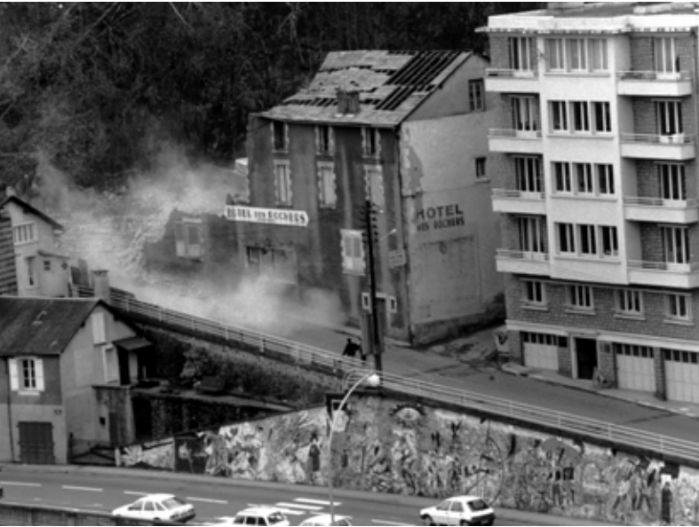
○ Démolition de l'Hôtel des Rochers (1989) - AM Tulle
