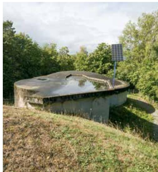
Le réservoir de Sourie dans le quartier des Fontaines possède une capacité de stockage de 2 000 m<sup>3</sup>. Il est désormais raccordé au réservoir du Puy des Ferrières pour alimenter les hauteurs de Tulle.
