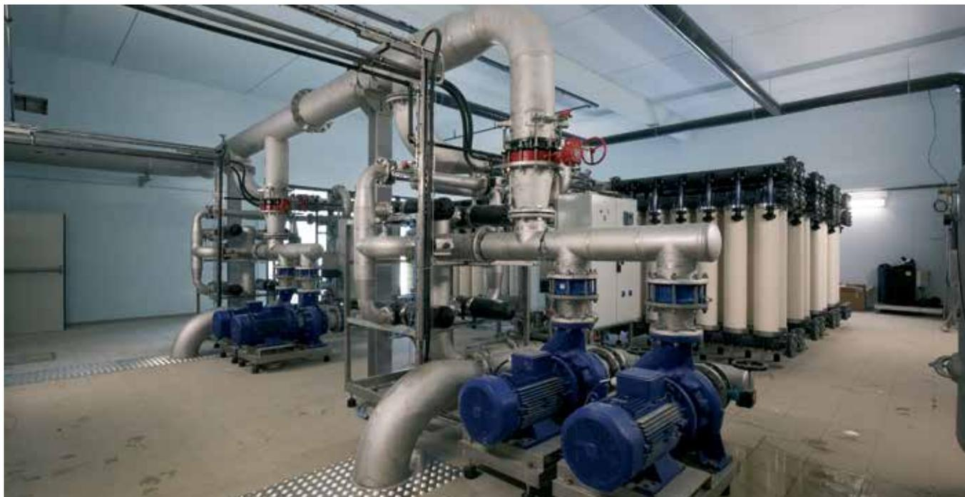
o La station des Carderies peut produire jusqu'à 11 100 m<sup>3</sup> au maximum par jour. Ces installations, et notamment les membranes d'ultra-filtration, permettent d'obtenir une eau pure d'Uzerche jusqu'à Tulle.
