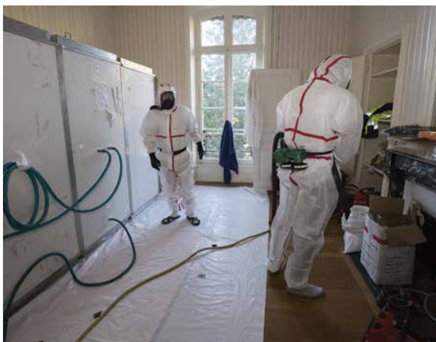
La société Alara a démarré les travaux de désamiantage dans les locaux de l'ancienne Banque de France. Les travaux de gros oeuvre commenceront au début de l'année 2021.
